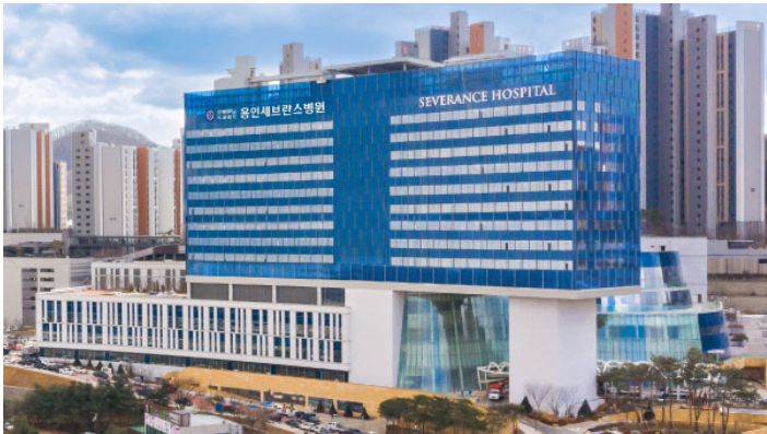
공사명 : 용인동백세브란스 병원 공사기간 : 2018.08 ~ 2019.11
