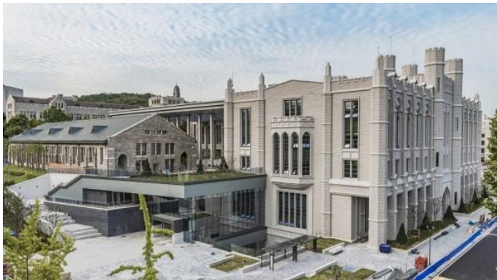
공사명 : 고려대학교 SK 미래관 공사기간 : 2018.04 ~ 2019.04
