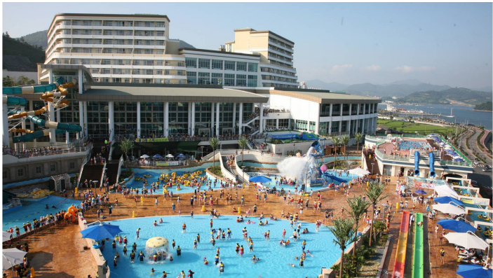
공사명 : 여수오션리조트콘도 및 옥내 W/P 공사기간 : 2008.04 ~ 2008.07
