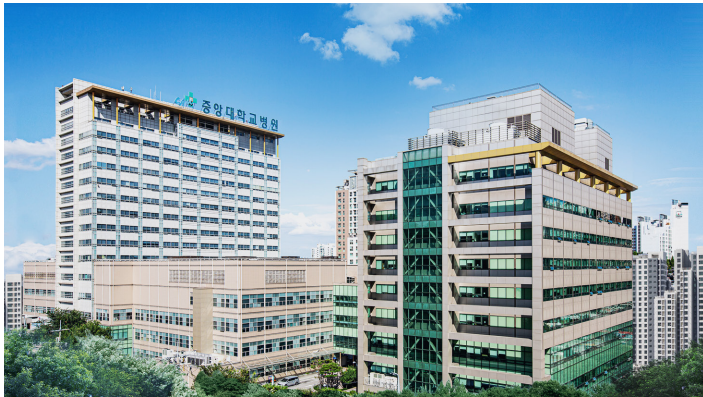
공사명 : 중앙대 병원 공사기간 : 2010.04 ~ 2010.10
