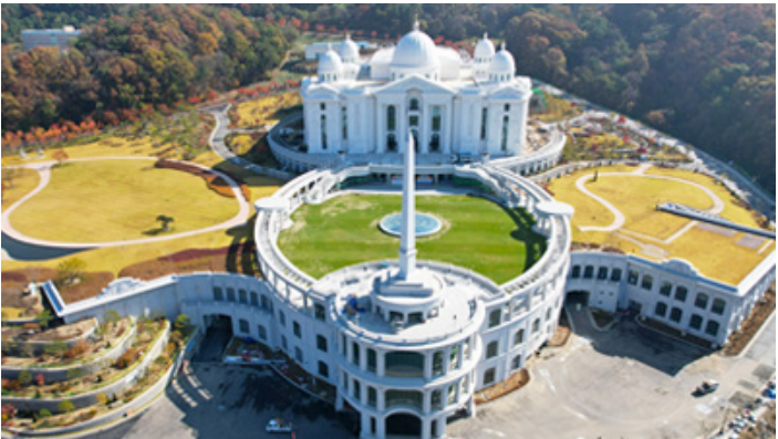
공사명 : 천지선학원 신축공사 중 외부석공사 공사기간 : 2020.07 ~ 2023.11
